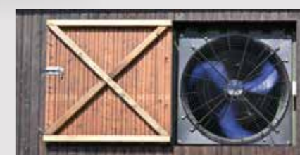
Der Ventilator wird, wenn möglich, in die Außenwand des Stalls eingebaut oder durch einen angrenzenden Raum mit ausreichend Luftvolumen mit der Außenwelt verbunden. Dieser ist mit dem Tube verbunden und versorgt den Stall mit Frischluft. 24 Stunden am Tag, an 365 Tagen im Jahr.
